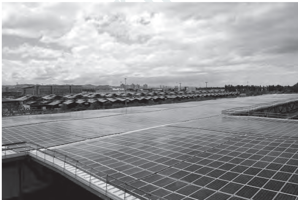
AREA DEL CENTRO AGROALIMENTARE DI BOLOGNA, IMPIANTI FOTOVOLTAICI SULLE COPERTURE DEGLI EDIFICI TRASFORMATI PER OSPITARE FICO / CAAB, FOOD AND AGRICULTURE CENTRE, PHOTOVOLTAIC SYSTEM ON THE ROOFS OF THE BUILDINGS TRANSFORMED TO HOST FICO (PHOTO CAAB SCPA)
